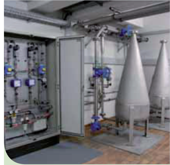
Abb. 2: Bicone™ mit Regelschrank zur \text{CO}_2 -Starkwasseraufbereitung
